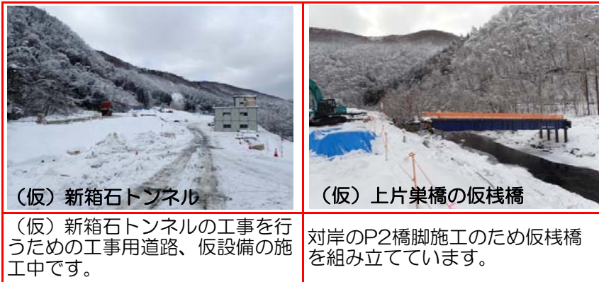
⑥施工：安藤・間
